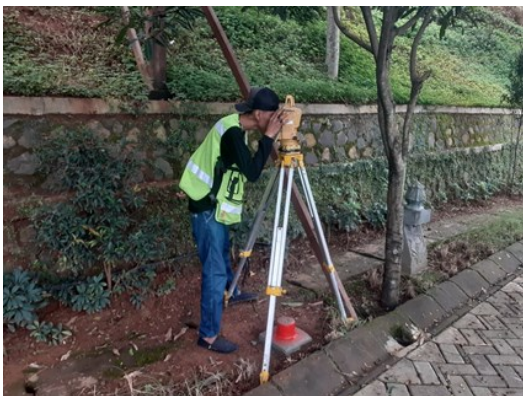
Gambar 6. Pengerjaan Survei Topografi
