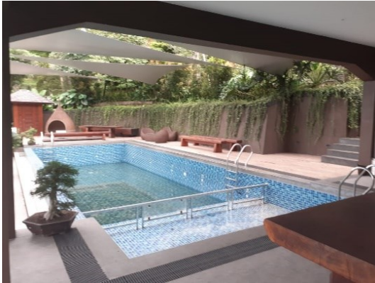
Gambar 1. Lokasi Keretakan Pada Dinding Kolam Renang
