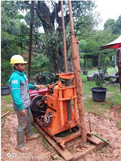
Gambar 5. Pengerjaan Deep Boring dan Standard Penetration Test (SPT)
